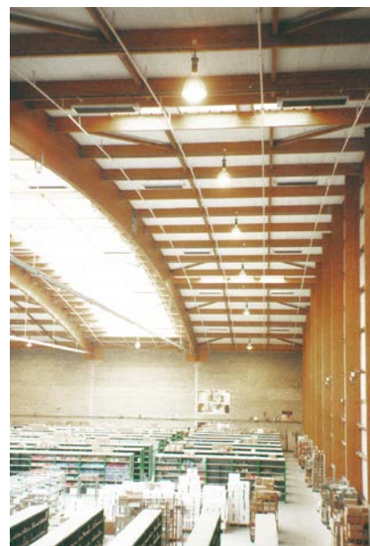
Особенно выгодно использовать инфракрасные обогреватели в помещениях с большой высотой потолков. Экономия по сравнению с традиционными видами отопления может составлять 30-40%.
