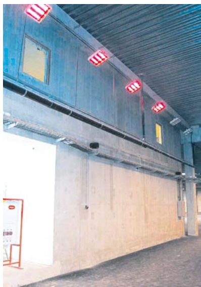
Приборы IRCF могут монтироваться как на стене, так и на потолке в помещениях, где обогрев требуется периодически, например, как на этой стартовой площадке картингистов на трек в Франции.
