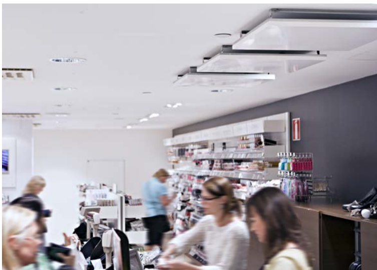
Локально добавить тепла в рабочую зону удобно с помощью потолочных кассет.
