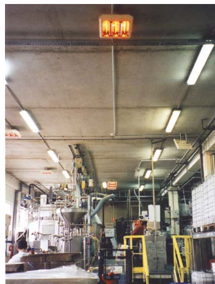
IRCF часто устанавливаются в складских помещениях. Обогрев приходит быстро и всегда эффективно, с быстрой окупаемостью приборов.
