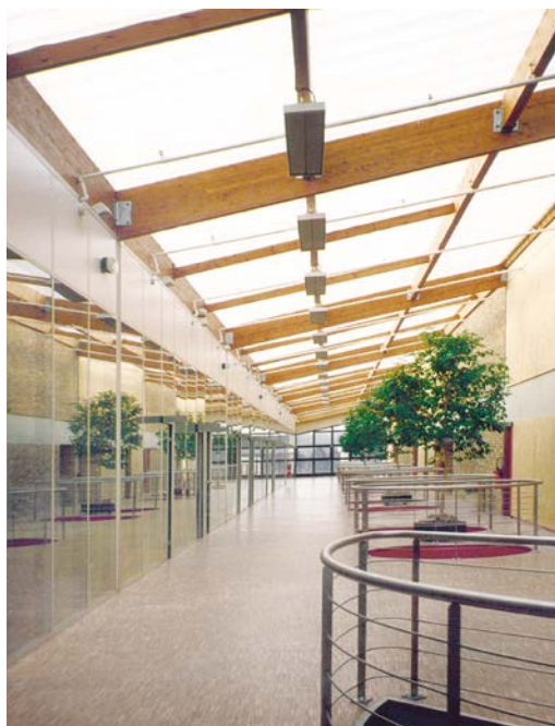
В коридорах часто бывает прохладно. Приборы EZ100 могут использоваться как дополнительный источник тепла.
