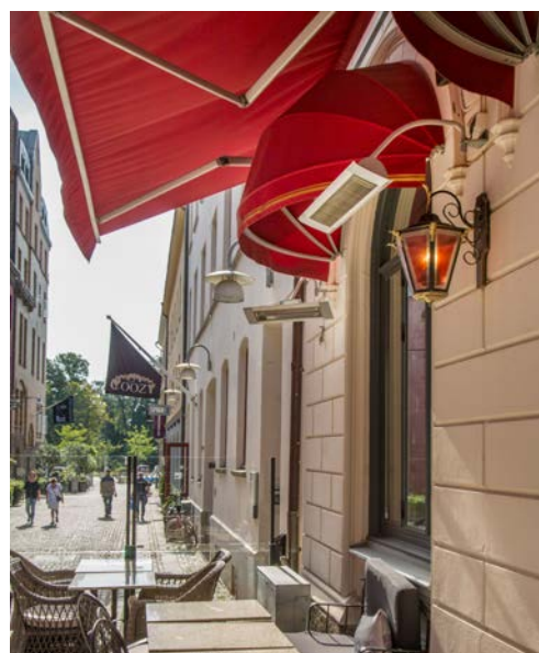
При использовании специальной штанги высота расположения самого прибора находится ниже относительно места крепления скобы на стене.
